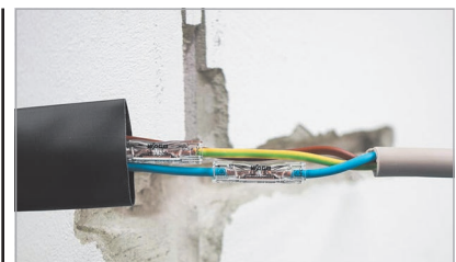
Рис. 4. З'єднання кабелю за допомогою термоусадочної трубки
